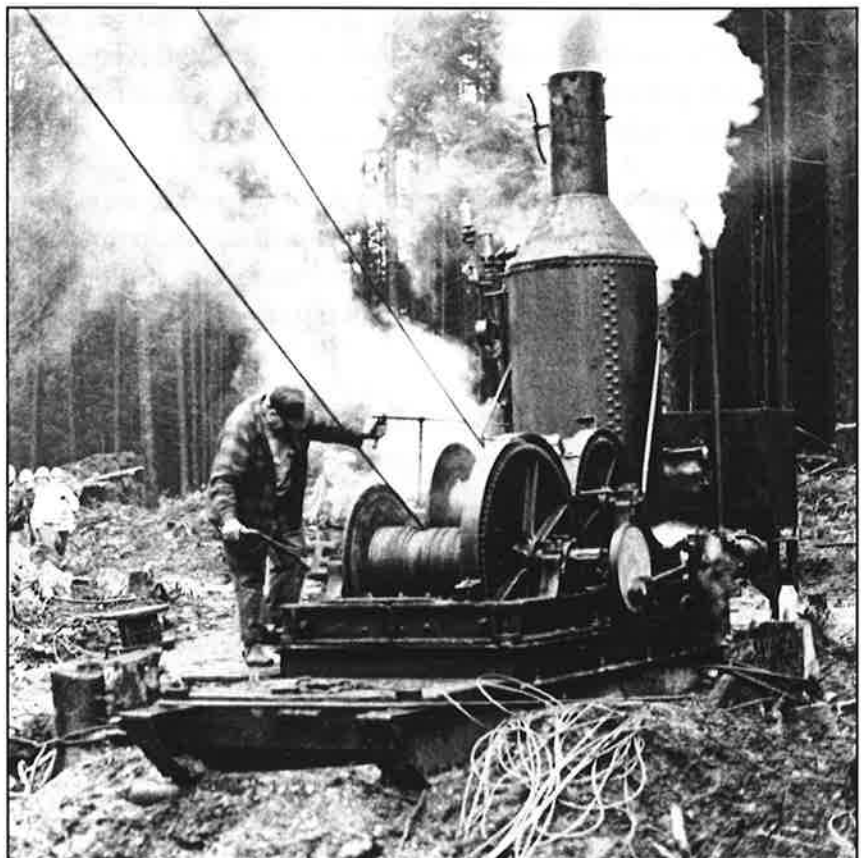
1. Treuil à vapeur de configuration originale, construit en 1885. Celui-ci a été remis en état et est visible actuellement dans l'état de Washington (extrait du calendrier 1994 de «Camp 2 Consolidated»).
